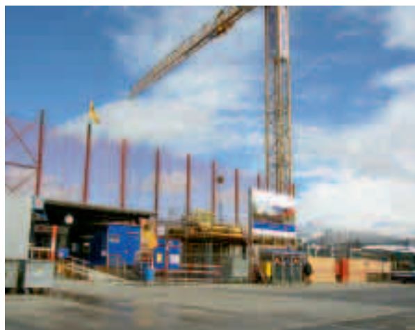
Baustelle am Bahnhof
