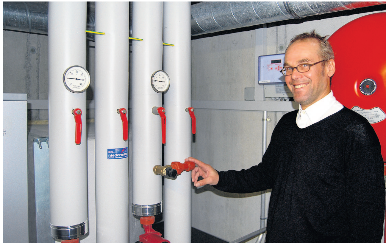
Heizungsingenieur Edgar Meier empfiehlt, Heizanlagen regelmässig prüfen zu lassen.
