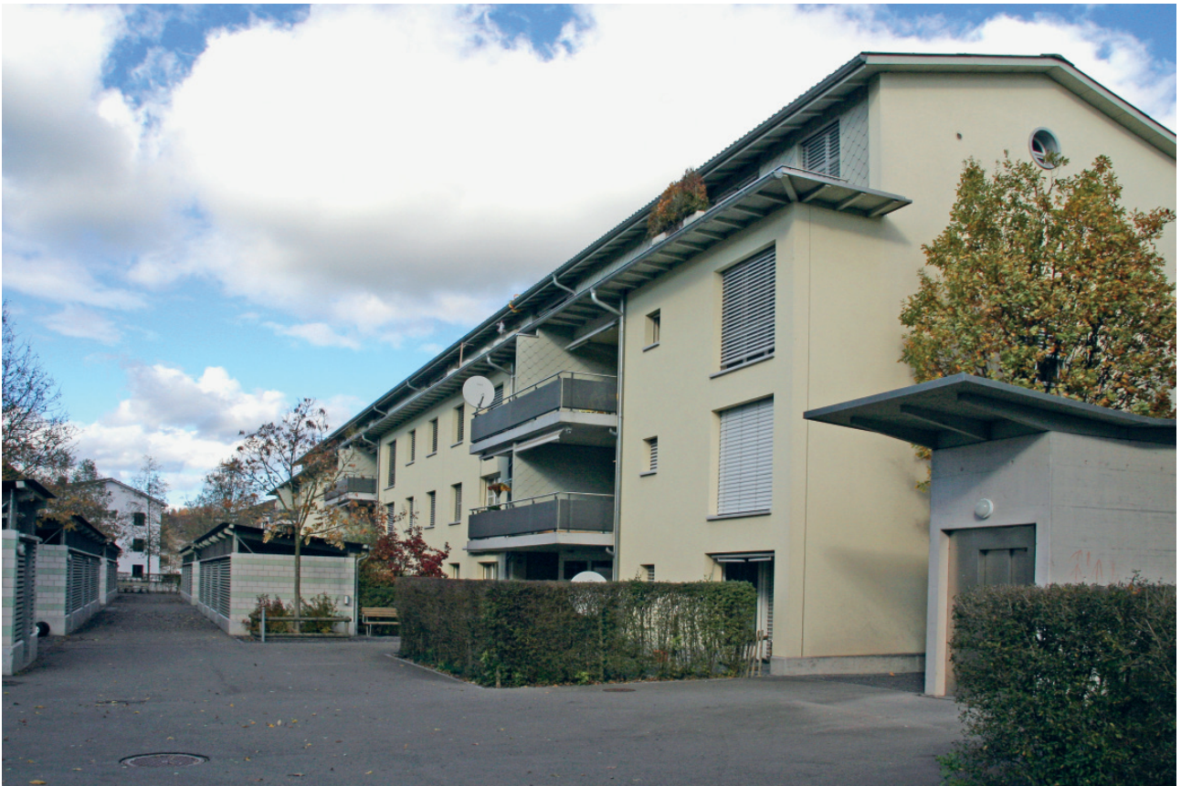
Beispiel für preisgünstigen Wohnungsbau – Überbauung Sagenbrugg
