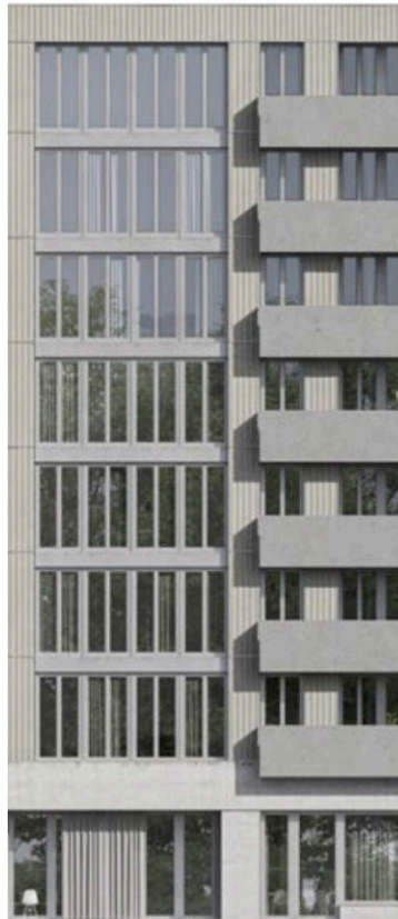
Baubereich 1Aa, 1Ab, 1Ac
