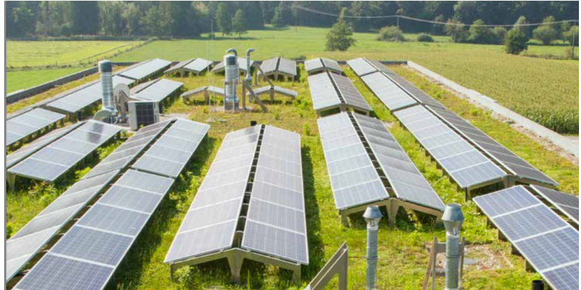
PV-Anlage in Dachbegrünung integriert (Quelle: ZinCo GmbH)
