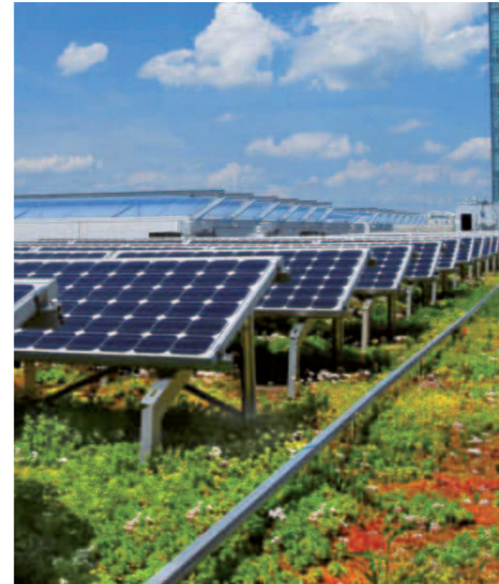
PV-Anlage Dachbegrünung
