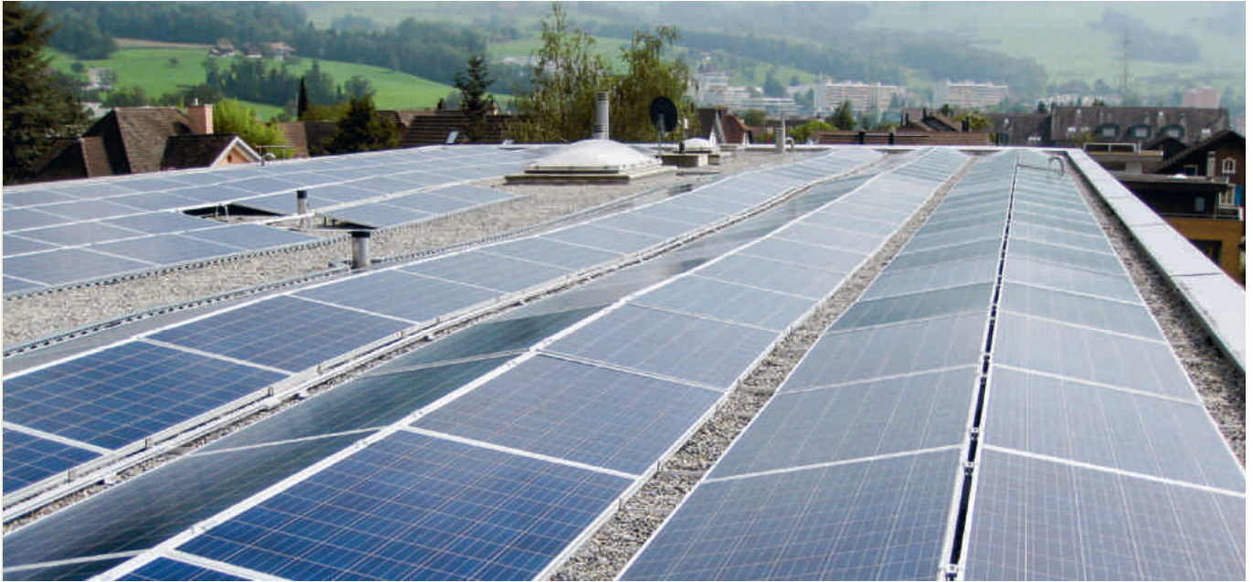
Beispiel PV-Anlage Schule Dorf matt
